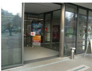
Blick auf den Haupteingang Kurhaus mit Eingangstür (rechts) zur TI
